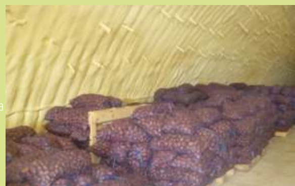
На фото: утепление вспененным пенополиуретаном.
