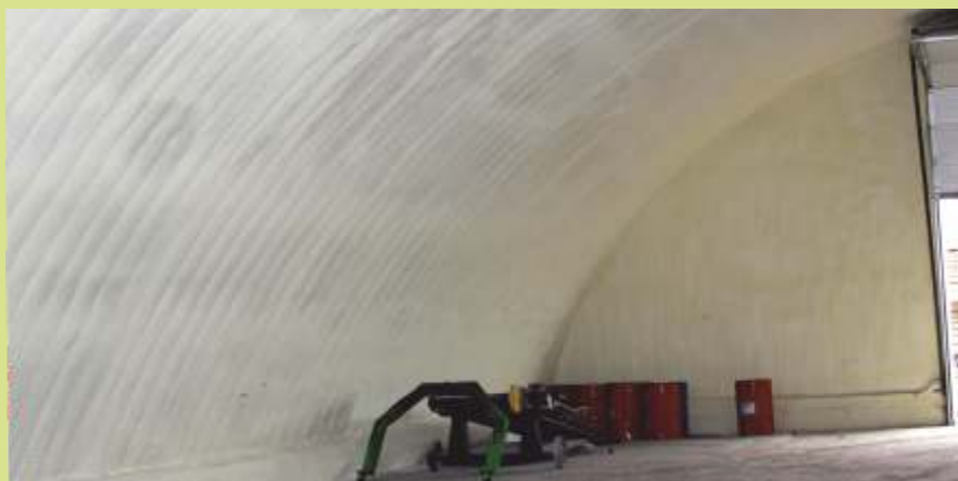
На фото: напыление вспененного пенополиуретана.
